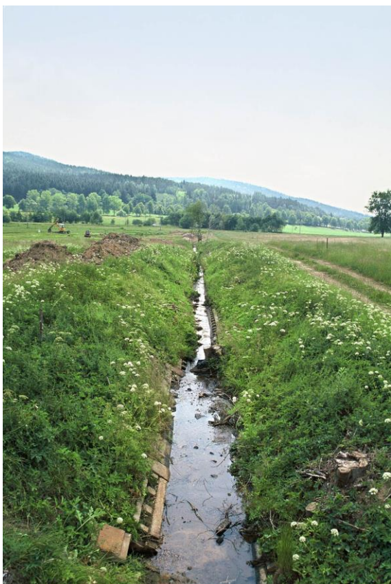
Stav koryta před revitalizací, detailní pohled na provedené opevnění při melioraci
