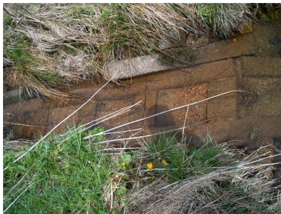
Stav koryta před revitalizací, detailní pohled na provedené opevnění při melioraci
