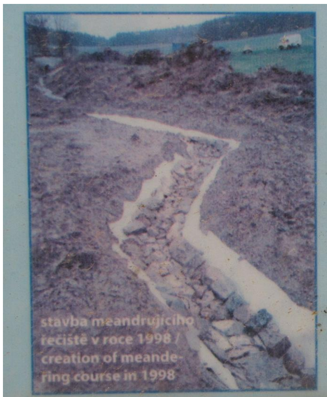
Stavba meandrujícího koryta v roce 1998
