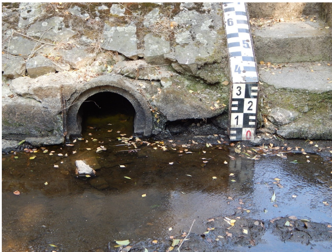
Obr. 5: Ukázka situace, kdy se přívodní kanál do šachty vodoměrné stanice postupně ocitl nad úrovní vodní hladiny, což vedlo k jeho zanesení a přerušení přívodu vody do měrné šachty vodoměrné stanice, přičemž současně došlo k poklesu hladiny pod nulu vodočtu (Úterský potok v Trpístech).
