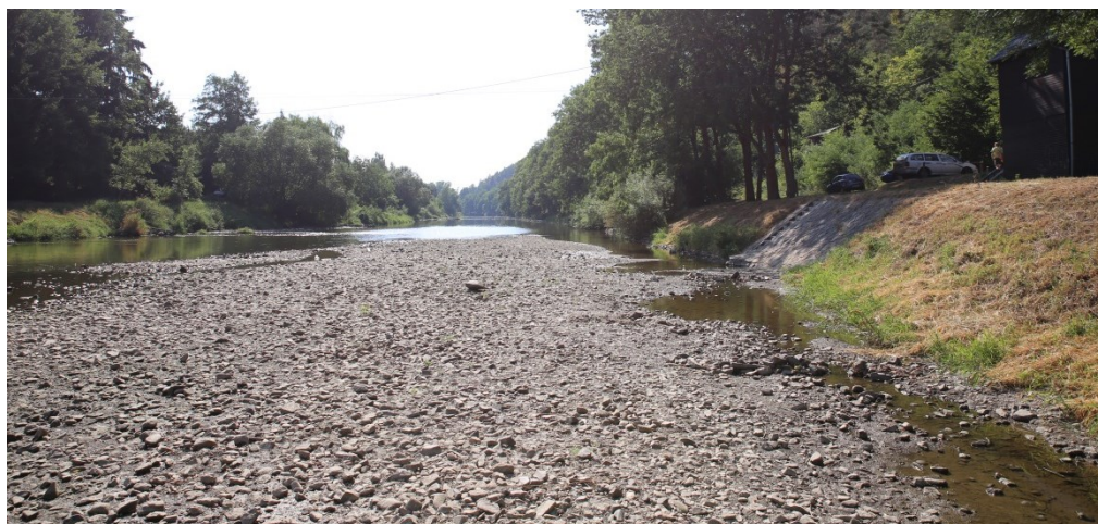
Obr. 1: Ukázka zanášení profilu na Sázavě v Nespekách, kde řeka ukládá štěrkový materiál u pravého břehu v místě vodoměrné stanice.
