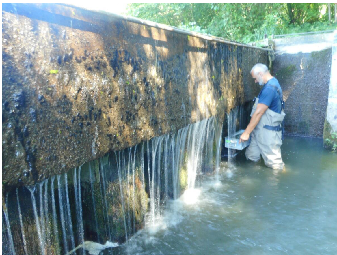
Obr. 61 Kontrolní měření do nádoby, hráz rybníka Lhotka
