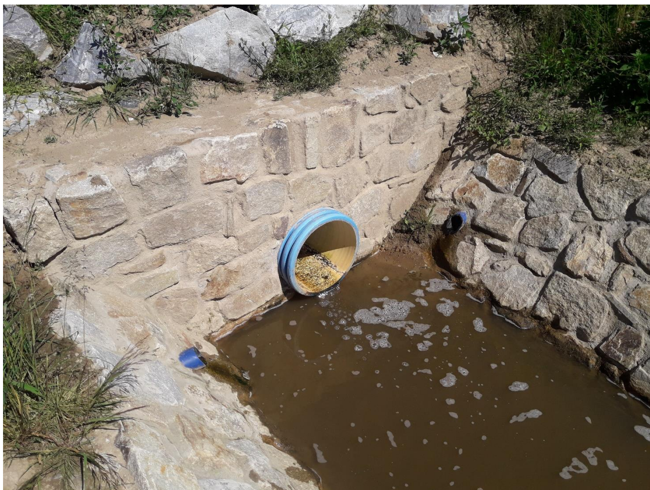
Obr. 67 Spodní výpust a vyústění patních drénů
