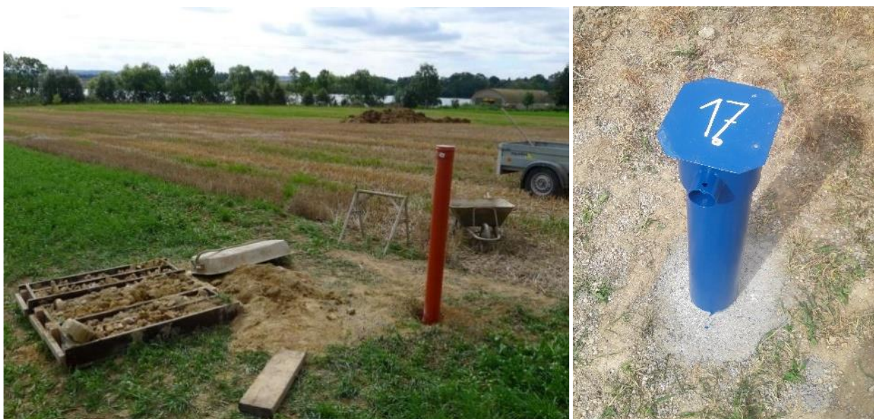
Obr. 17 Dokončený vrt 17 na pravém svahu rybníka Vavřinec (vlevo - vrt vystrojený plastovým potrubím, vpravo - osazené ocelové zhlaví).
