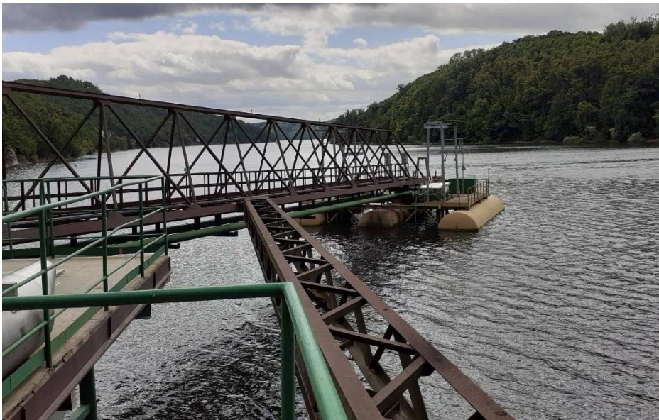
Obrázek 13 Plovoucí čerpací stanice na nádrži Vranov, která odebírá surovou vodu pro úpravnu vody Štítary.
